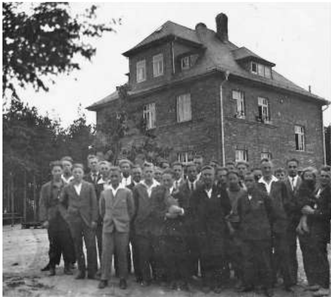
im Rohbau befindliches Vereinshaus mit Mitgliedern des Arbeitersportvereins „Vorwärts“
