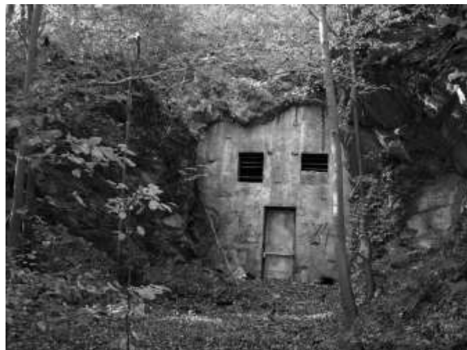
Das Bild zeigt einen Stolleneingang. Diese Tür und die Fenster wurden zu DDR Zeiten gesetzt. Der Stollen wurde dann als Gemüselager genutzt.
