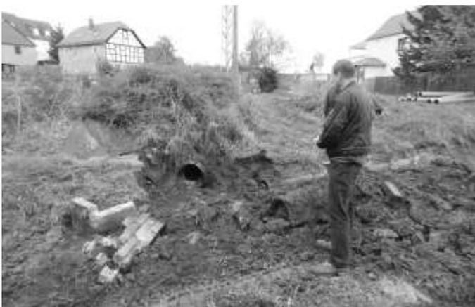
Stets im Einsatz ist der Hohenleubener Bauhof. Hier im Bild sehen wir die Sanierung des maroden Überlaufschachts am Dorfteich Brückla, wodurch künftig wieder stetiger für eine angemessene Qualität des Löschwassers zulaufs gesorgt wird.
