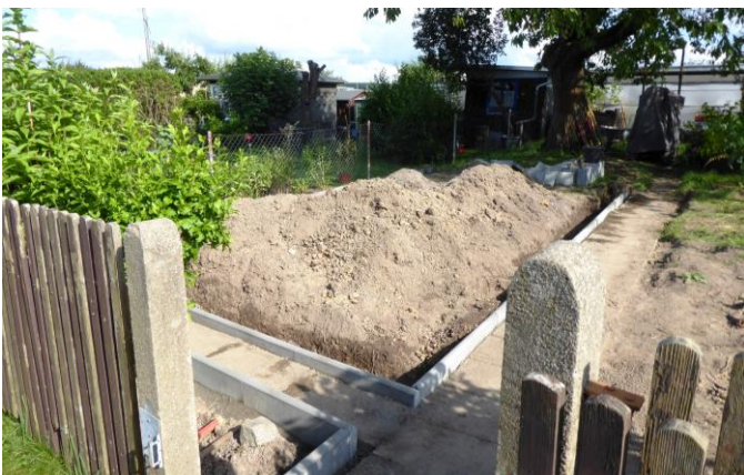
Im Rahmen der Umgestaltung der Kindergarten-Parzelle musste viel Erdreich bewegt werden. (© Monique Scholz)
